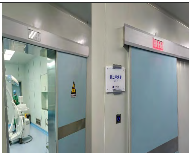
门灯联锁(患者防护门关闭警示灯自动亮起)
