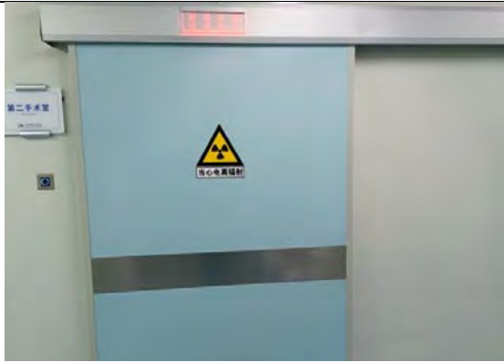
患者出入口设置的放射性标志、中文警示说明和 “射线有害 灯亮勿入” 警示灯
