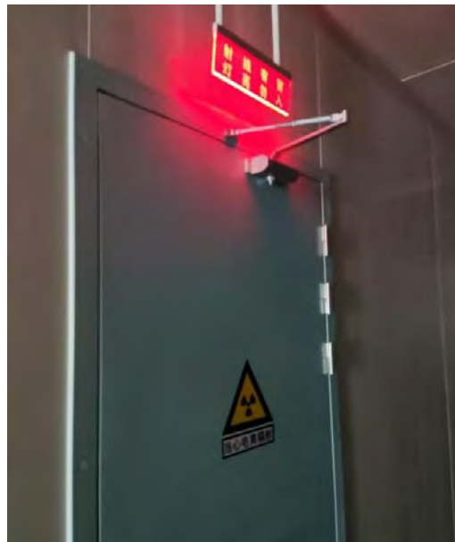
污物门外设置的放射性标志、中文警示说明和 “射线有害 灯亮勿入” 警示灯
