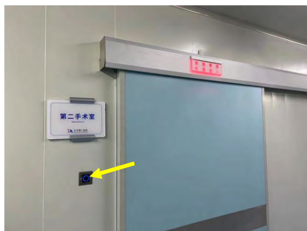
无接触手触式门控制开关
